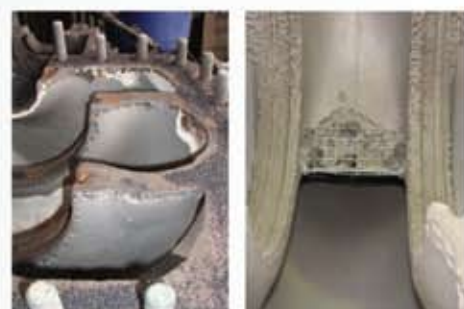
Пример точечной коррозии Восстановление полностью изношенной поверхности
