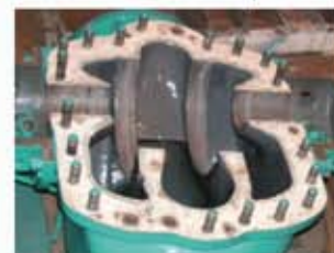
Оборудование отремонтировано и готово к сборке
