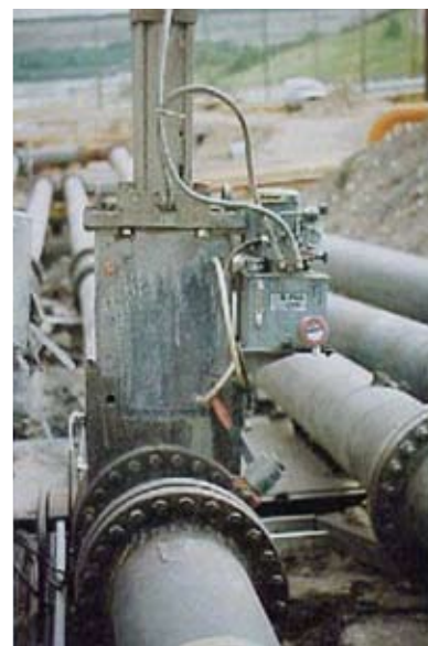
Первая в мире ножевая задвижка класса ASME 300 для рабочего давления 50 бар.
