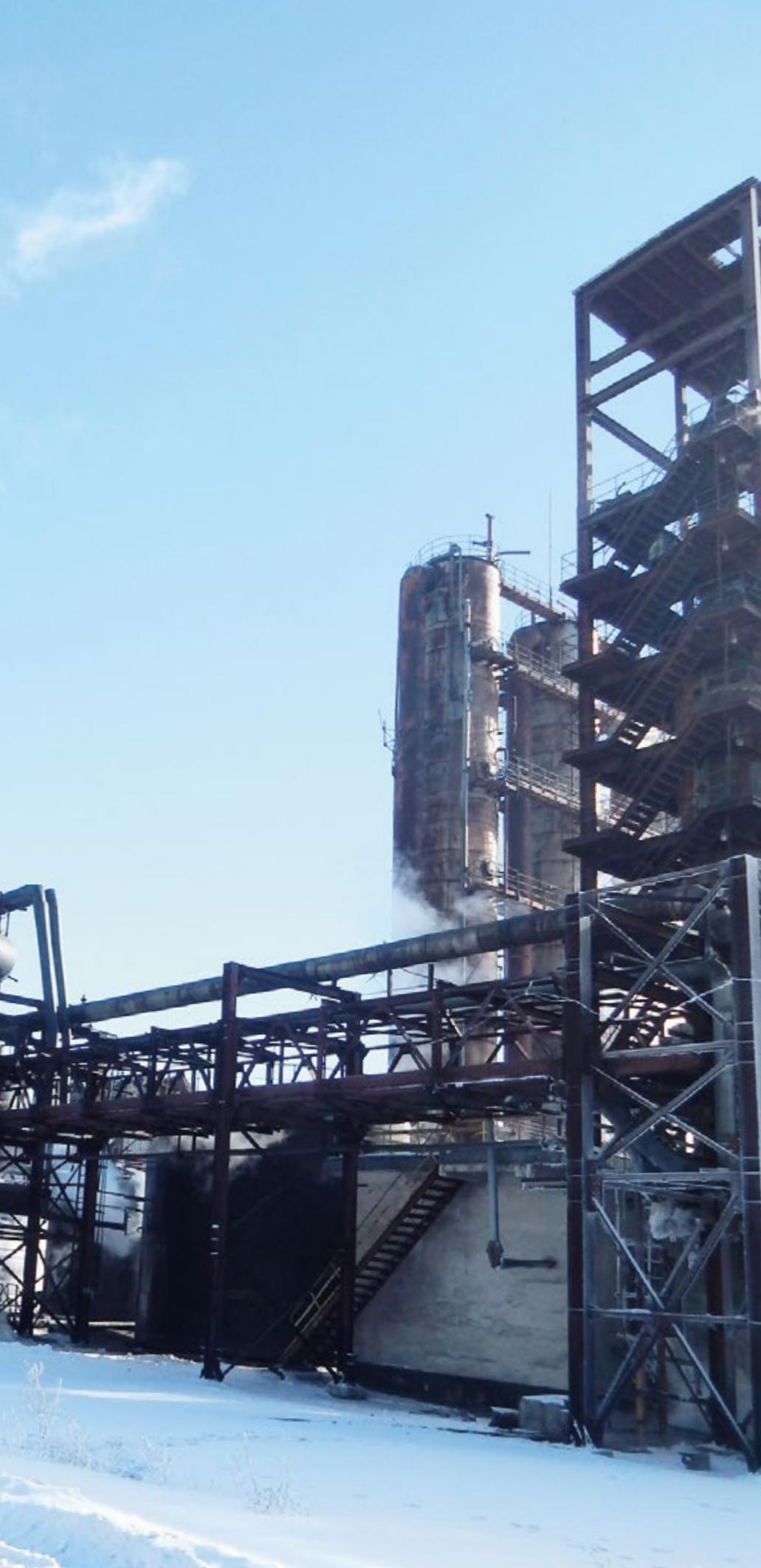
Еще одна его «придумка» — установка подогревателя аммиачной воды и использования парового конденсата. Раньше аммиачная вода, проходящая отстойники и идущая на переработку, сильно остывала и в таком виде поступала на колонну с температурой 110 градусов. Шел перерасход пара, тот конденсировался, отчего увеличивалось количество сточных вод.
