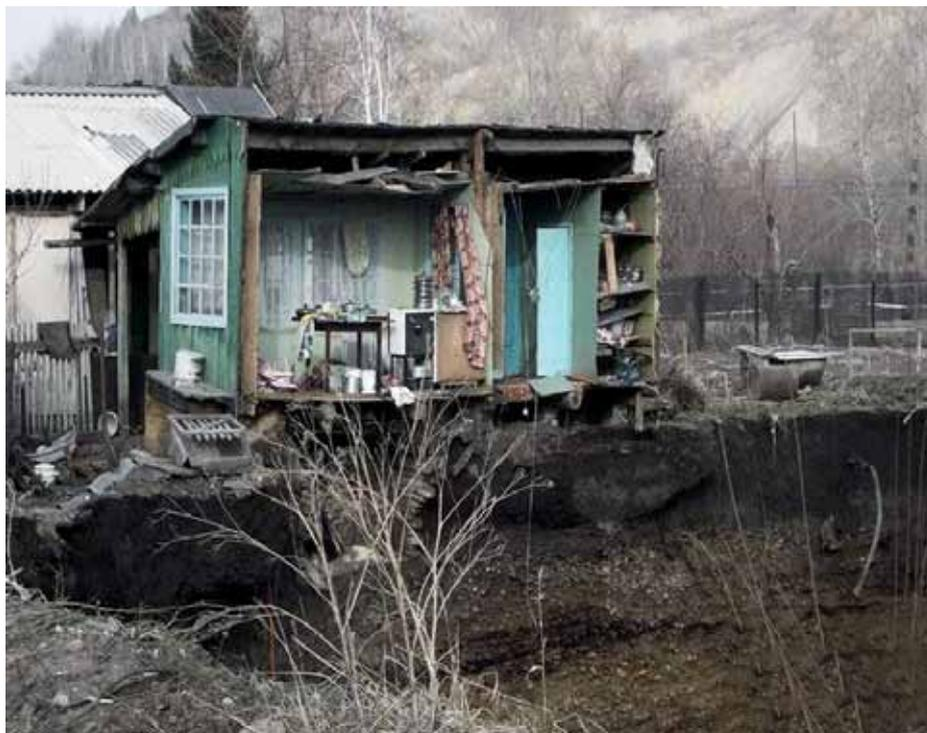
разрушение кровли одной из камер залежи «Быструшинская» на 11-м горизонте.
