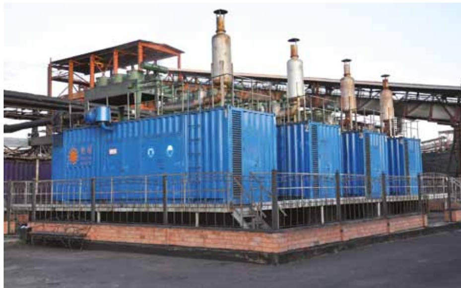
С вводом в строй первой очереди ТЭС на коксовом газе были закрыты собственные нужды завода по производству спецкокса, а с вводом второй очереди планируется обеспечить потребности АО «Шубарколь комир». Принцип работы ТЭС основан на применении технологии выработки электроэнергии с помощью газо-поршневых установок производства КНР. Они апробированы на предприятиях, аналогичных ТОО «Сары-Арка Спецкокс» и работают на низкокалорийном коксовом газе.
