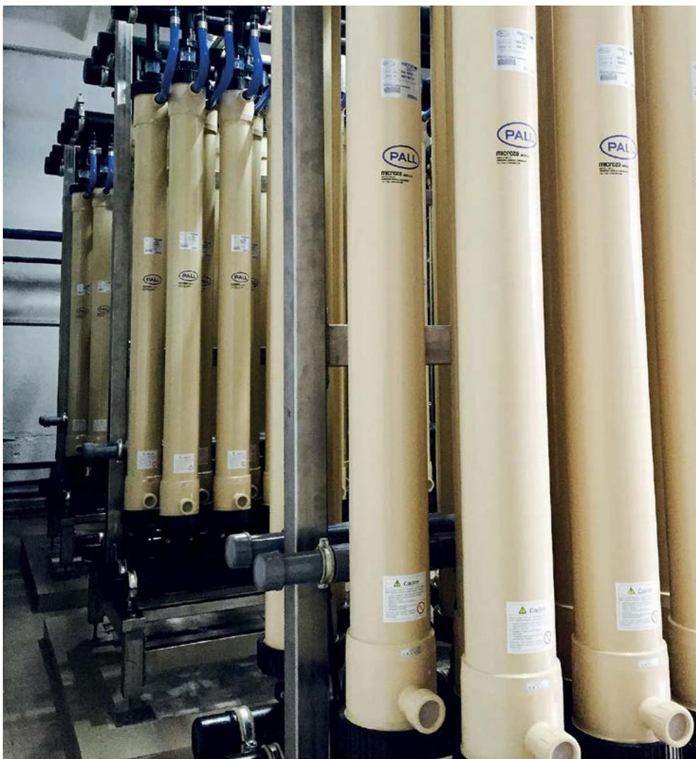
микроорганизмов, вирусов, железа и марганца, мышьяка. Концентрация нитратов снижается до 15-20%. В результате применения технологического решения Pall стабильное высокое качество воды на выходе (фильтрат) не зависит от качественных показателей подаваемой воды на Pall Aria Multirack.
