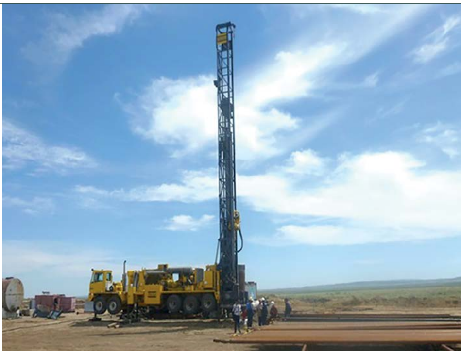
Рисунок 3. Буровая установка Atlas Copco RD20.
