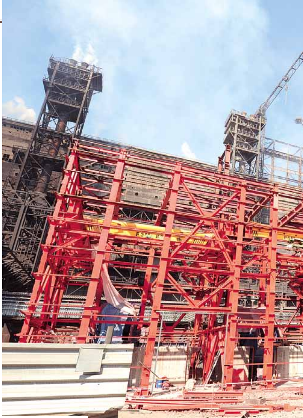
СТРОИТЕЛЬСТВО СИСТЕМЫ ГАЗООЧИСТКИ КОНВЕРТЕРНОГО ЦЕХА
